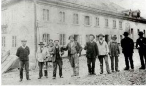
Ouvriers du chantier du Remblai, de 1873 à 1876
